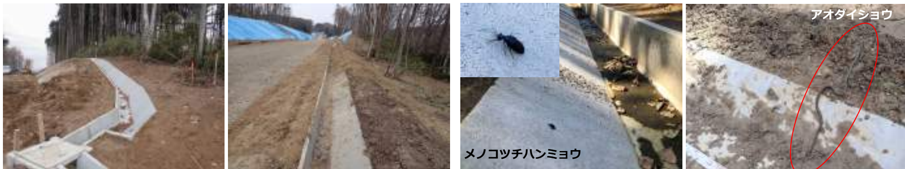
スロープ付き側溝
