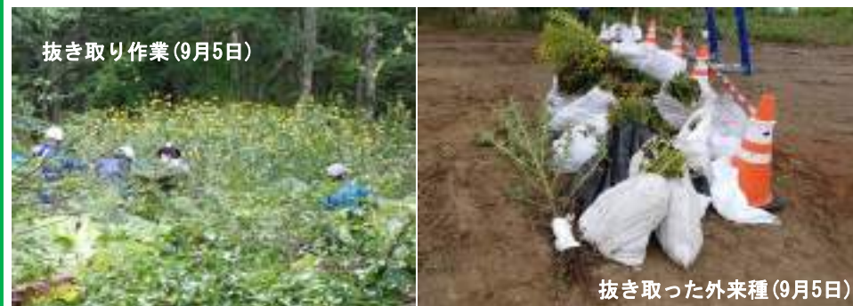
外来種駆除の状況（工事関係者による一斉除去）
