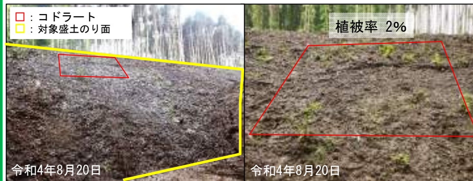
法覆基材施工箇所（植被率が最も低いコドラートNo.4付近）
