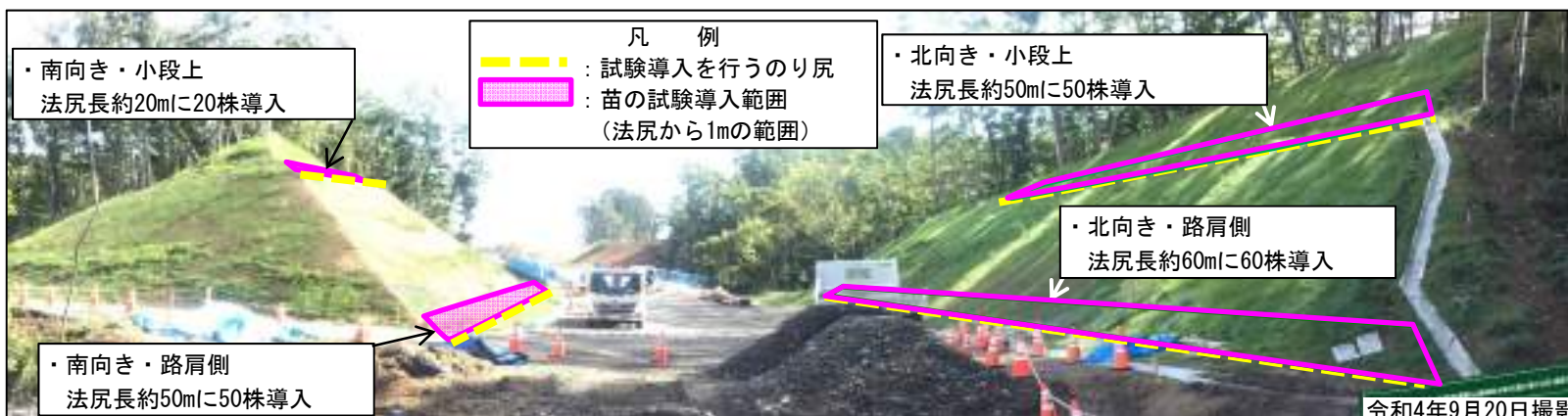
図24.切土法面への苗導入試験イメージ (SP2220~2280付近)
