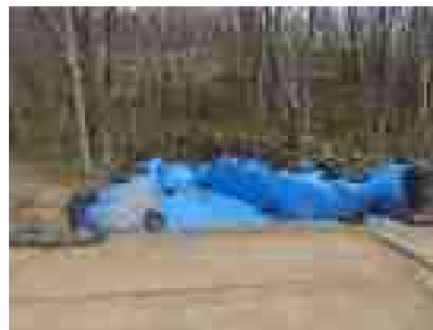
【濁水対策】 大型土のうによる簡易沈砂池・土のうによる簡易泥溜
