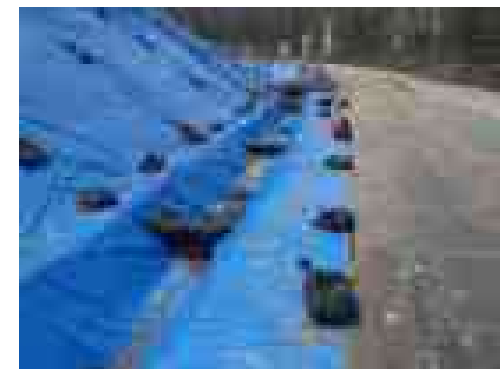
【濁水対策】 大型土のうによる簡易沈砂池・土のうによる簡易泥溜
