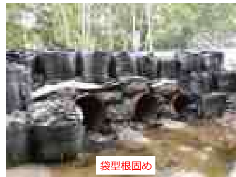
【濁水対策（工事用道路）】 土を使用せず袋型根固めを用いた河川横断
