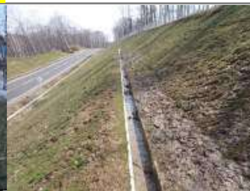
切土法面小段足跡（R5.4.10）
