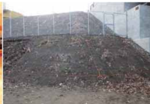
盛土法面（3号橋）
