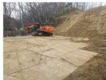
3号橋下 産卵場埋め立て状況 R3.4.15
