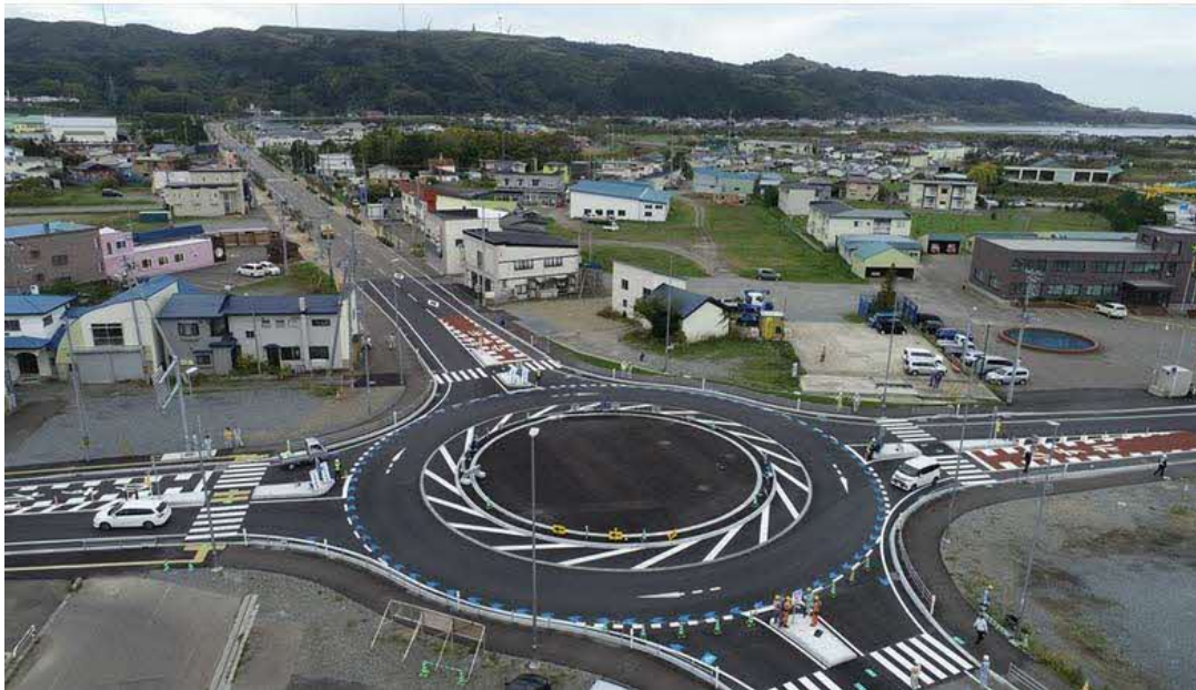
資料：檜山管内上ノ国町に設置されたラウンドアバウト（上ノ国町資料）
