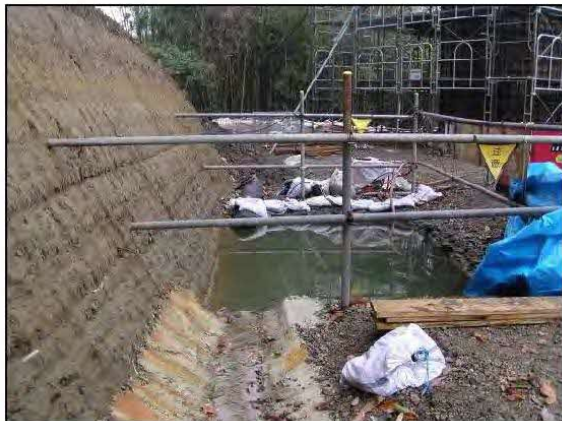
⑤沈砂池No.2の状況
