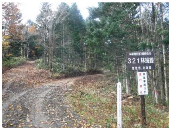
林業専用道(新設)
