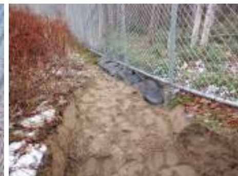
ドレスネット下の洗堀 (R5.11.7) ・補修後 (R5.11.28)
