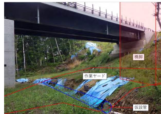
工事用道路・ヤード拡大
