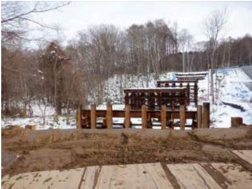
Fビレッジ245橋（旧1号橋） 仮橋上部撤去（11月）
