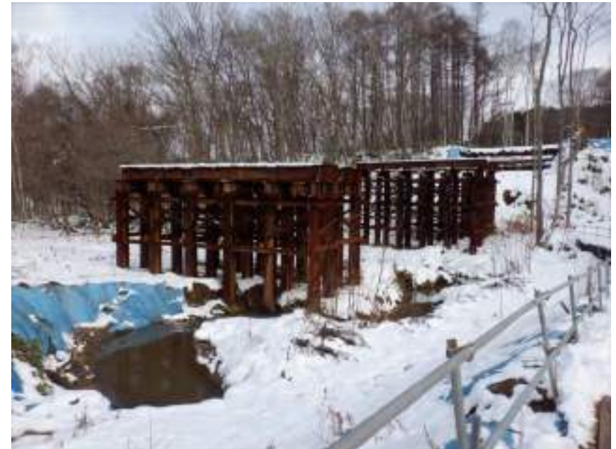
Fビレッジ245橋（旧1号橋） 仮橋上部撤去（11月）
